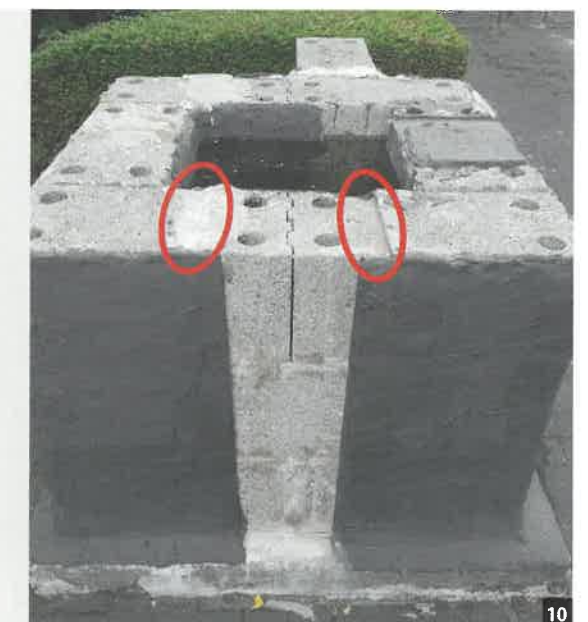
Abb. 10: Der mit einem Betonkern verschlossene Übergang funktioniert ab einer Schlitzbreite von circa drei Zentimetern zuverlässig.
